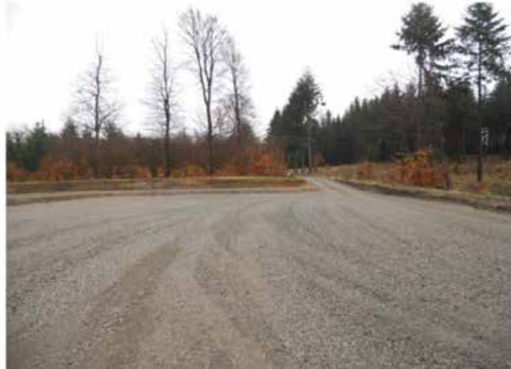
Figure 159 : Exemples de plateformes au pied d'éoliennes en milieu forestier (source : ABO Wind, 2015)
