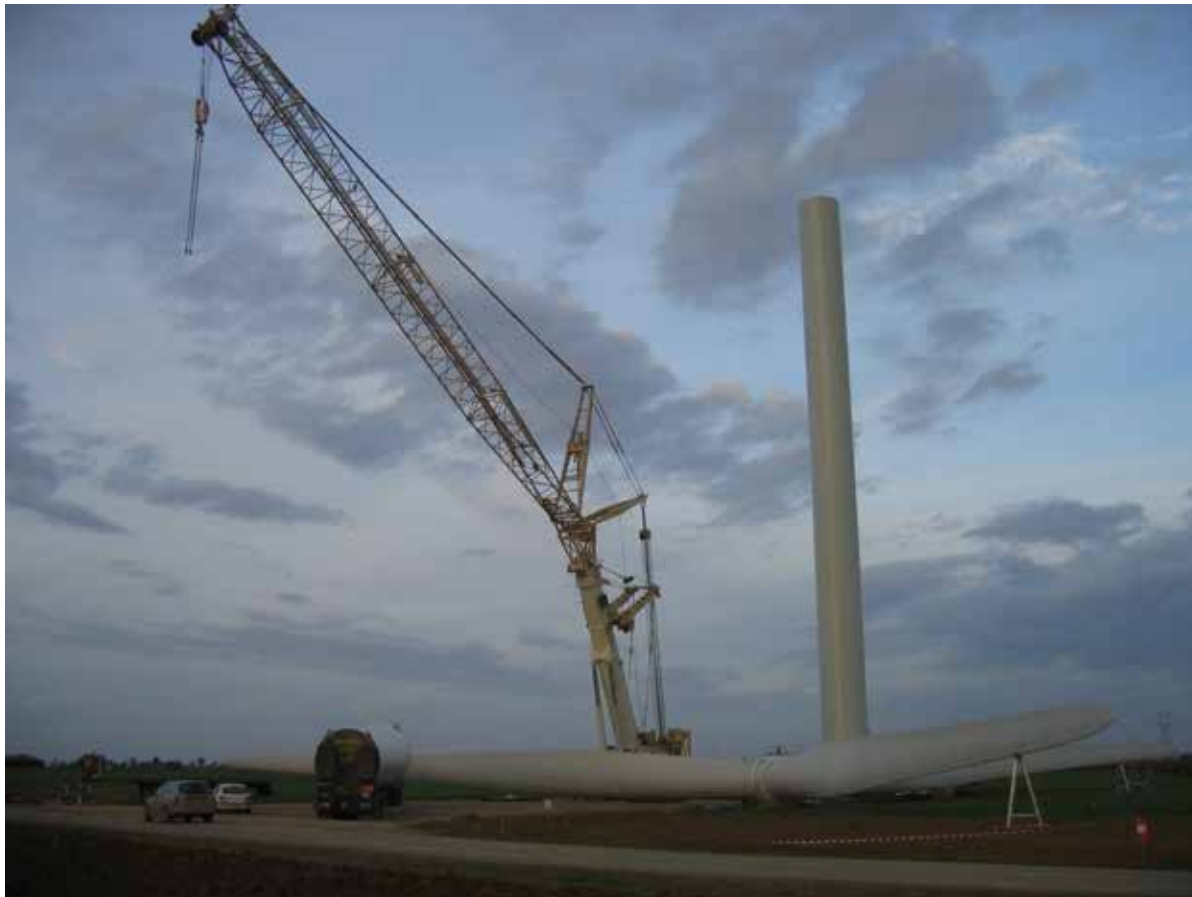
Figure 124 : Illustration d'un chantier
