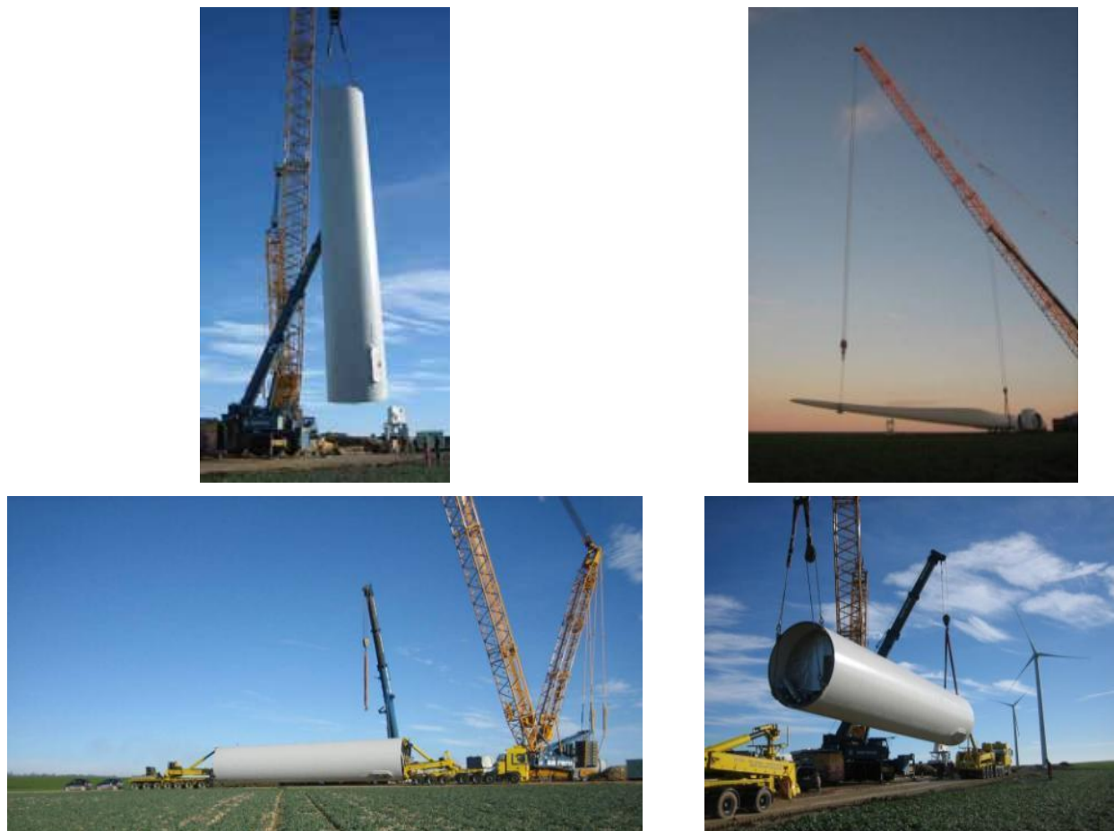
Figure 115 : Illustration du montage d'une éolienne – mât et rotor (source : ABO Wind, 2014)
